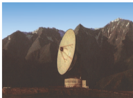
41-сүрөт. Жызак облусу Заамин тоолорунун этегинде курулуп жаткан, металл күзгүсүнүн диаметри 70 метрлүү радиотелескоп.
