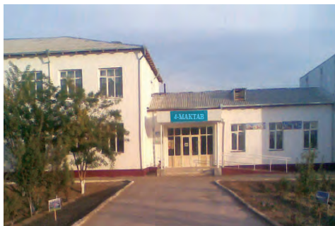
Mekdep binasy. 1991–2000-nji ýyllar
