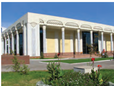
Бейнелеу өнері галереясы
