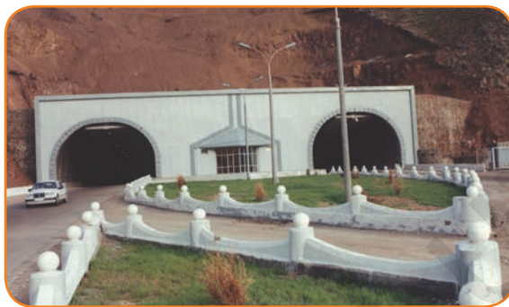
74-сурет. Камчык ашуусундагы тоннель.
