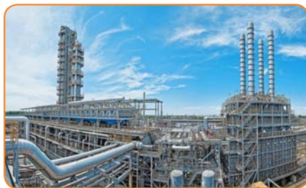
Рис.34. Шуртанский газо-химический комплекс.
