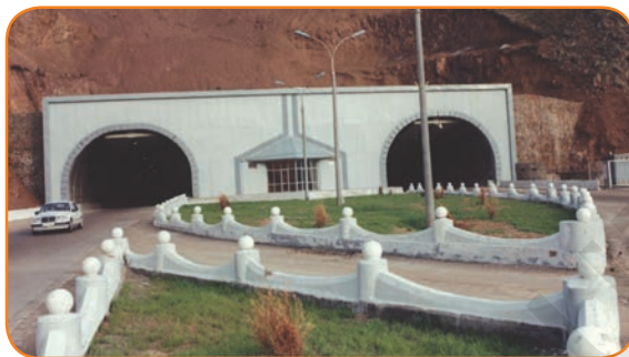
Рис. 74. Тоннель через перевал Камчик.
