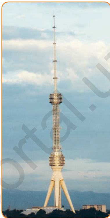
Рис. 77. Ташкентская телебашня высотой 375 метров.
