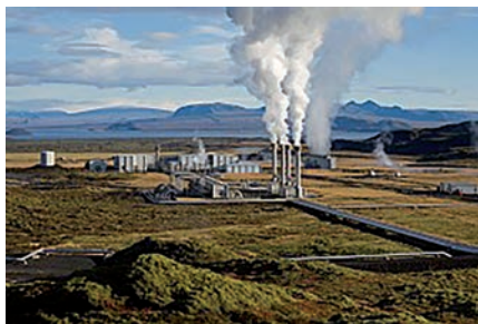
4-сүрөт. Исландиядагы геотермалдык электр станцияларынын бири.
